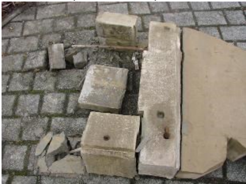
zerstörtes Fundament des Mahnmals in Rohrbach, 18.02.2012
